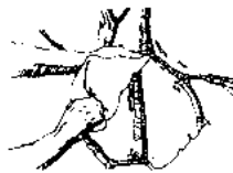
Figura 13 Enlechado de juntas.
