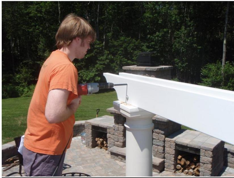
HOLD LINTELS IN PLACE AGAINST THE POST CORE WITH A CLAMP. USE EIGHT INCH LONG ½” DRILL BIT TO DRILL THRU EACH LINTEL AND THE STEEL POST CORE IN A SINGLE PASS.
